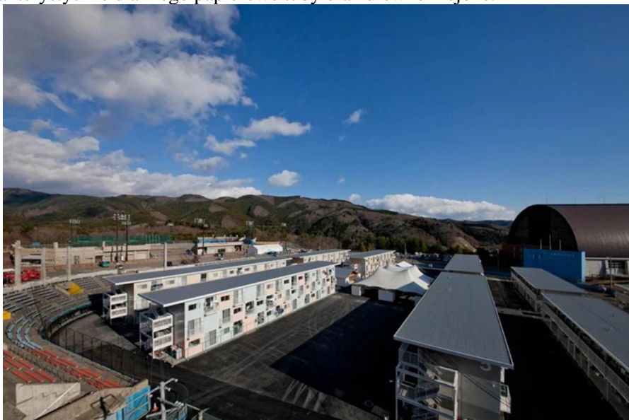
Rysunek 4. Mieszkania wykonane z kontenerów transportowych, Onagawa, proj. Shigeru Ban.
